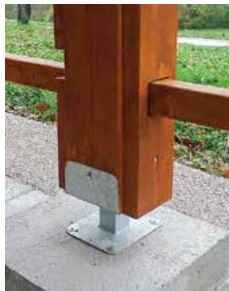
a) pritrditev na betonski podstavek
