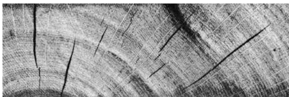
Slika 310: Zaskorjen les z notranjimi razpokami (X)
