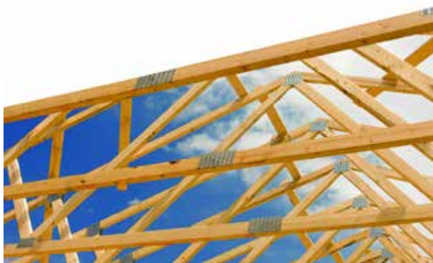
Slika 284: Ostrešje zaščiteno pred insekti, trohnenjem in modrenjem (X)
